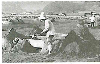
▲入浜式塩田(昭和20年頃) 海水は塩田に浸透すると表面に染み上がる。日光や風により水分がとばされ表面の砂に塩分が付着する。
